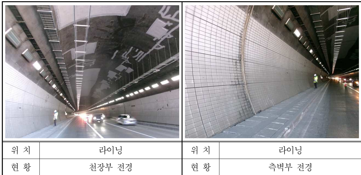
【사진 2.1.4】 라이닝(천장부, 측벽부) 전경
